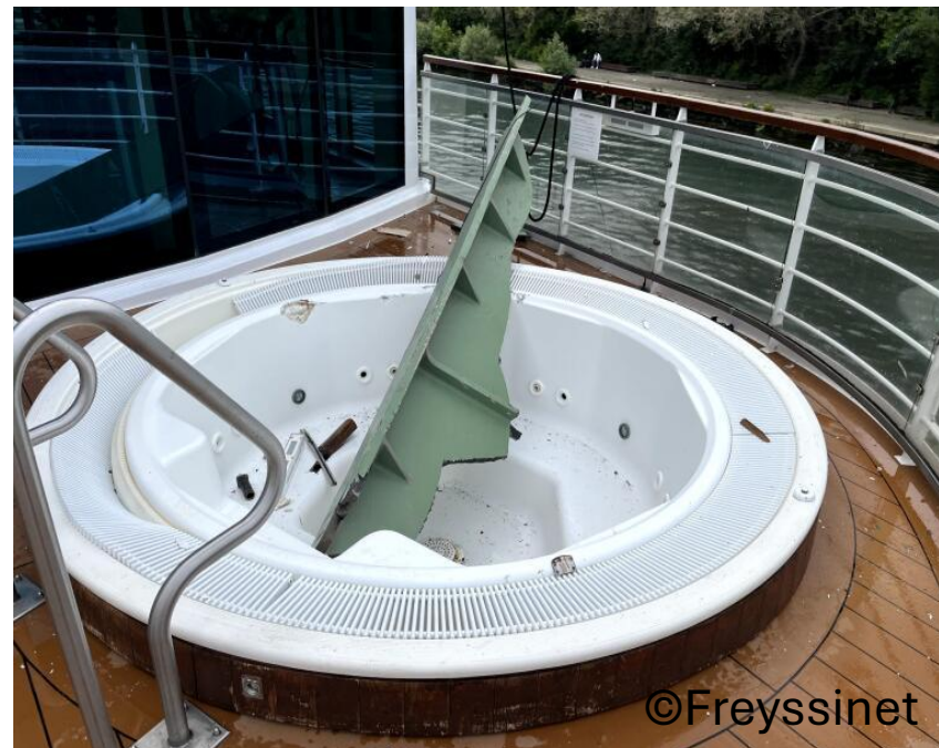
Élément Porteur Endommagé
