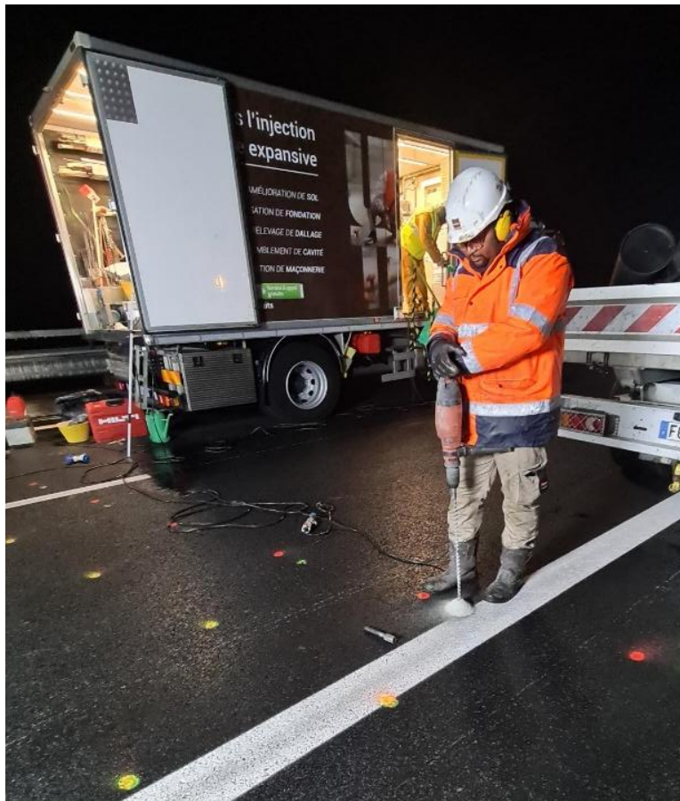
Percements manuels de faible diamètre
