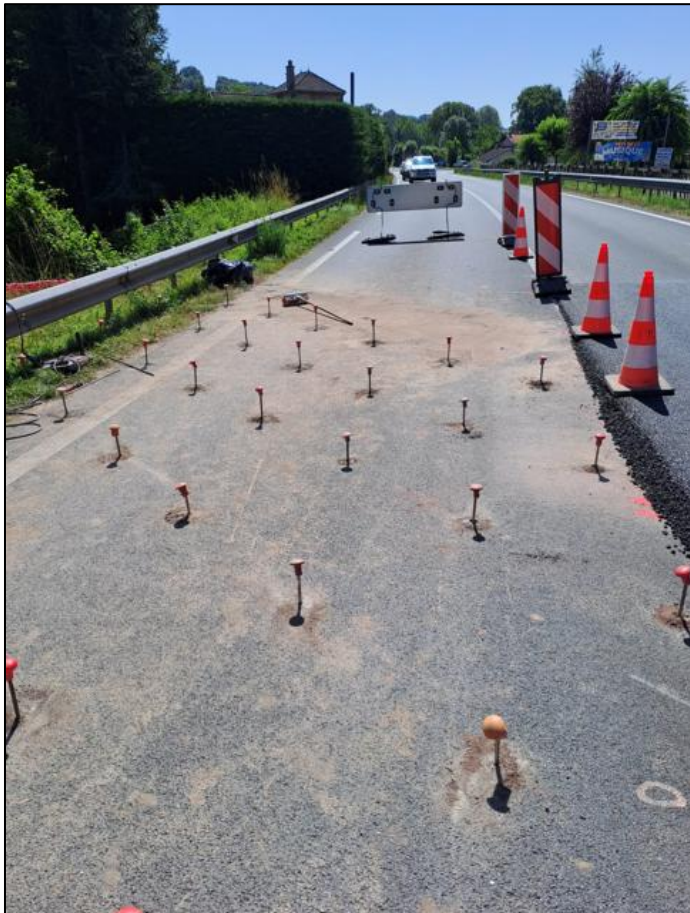
Mise en place de tubes acier Ø12mm
