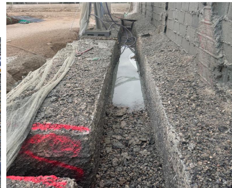
Hydrodémolition d'une dalle à Bezons
