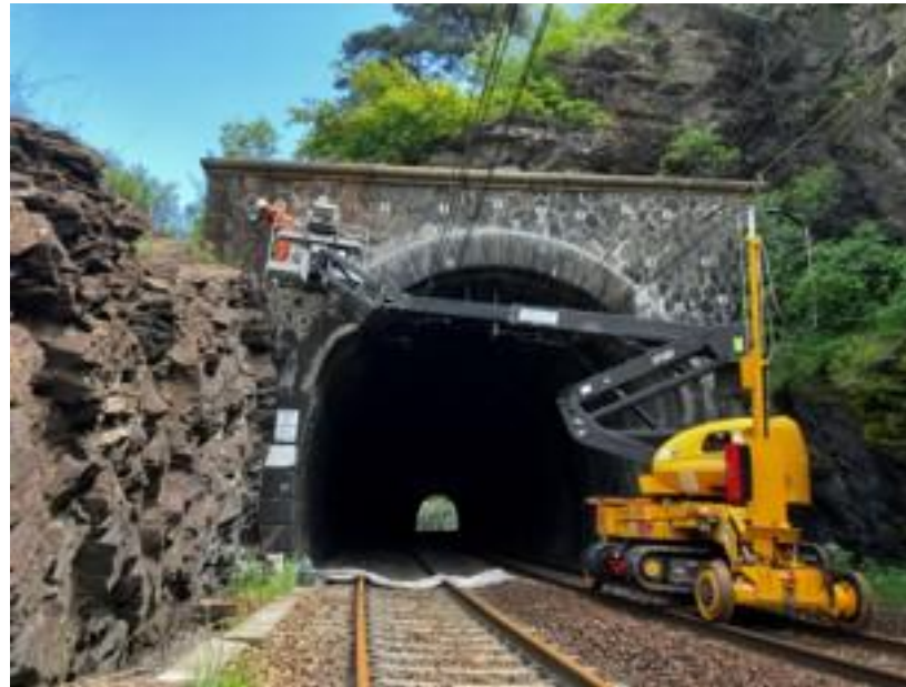
Entretien d'ouvrages maçonnés
