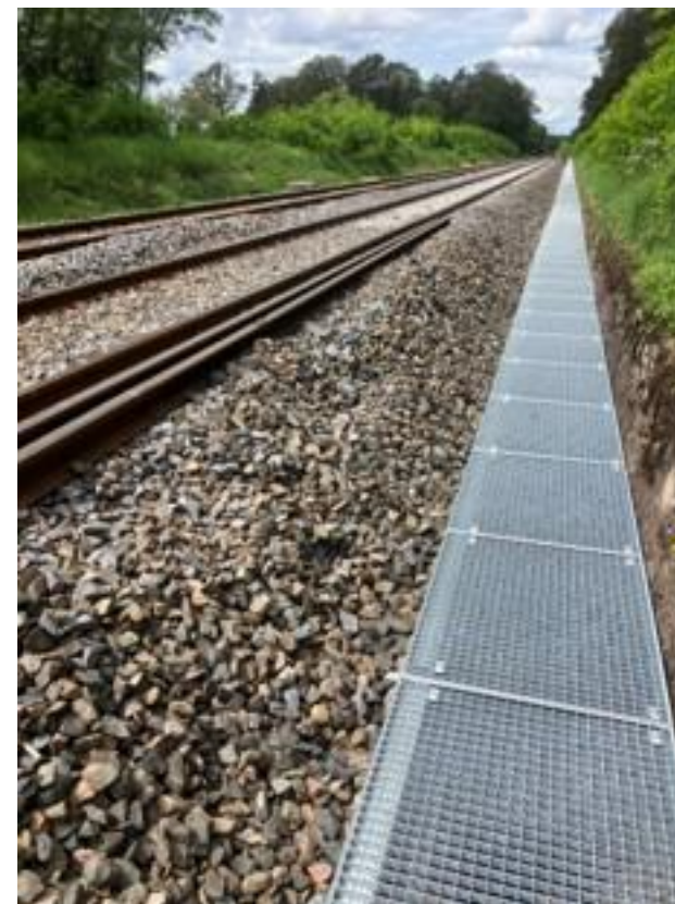
Drainage de plateforme ferroviaire
