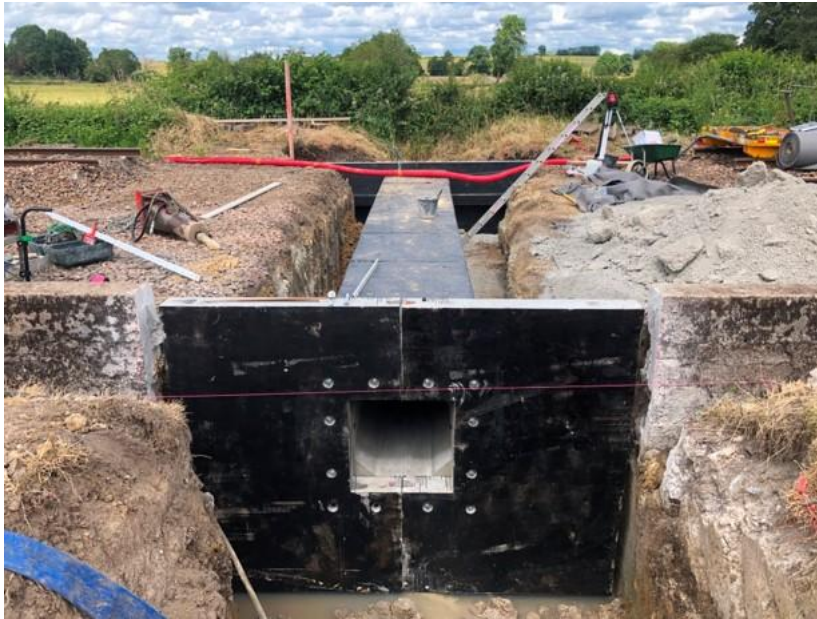
Remplacement d'ouvrages sous voies
