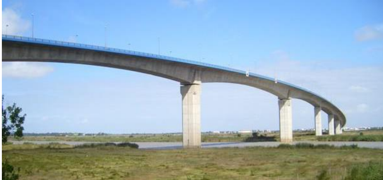
Viaduc de Martrou franchissant l'estuaire de la Charente à Rochefort-sur-Mer
