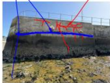
(1) Face avant du voile béton faisant office de moilage du mur existant
