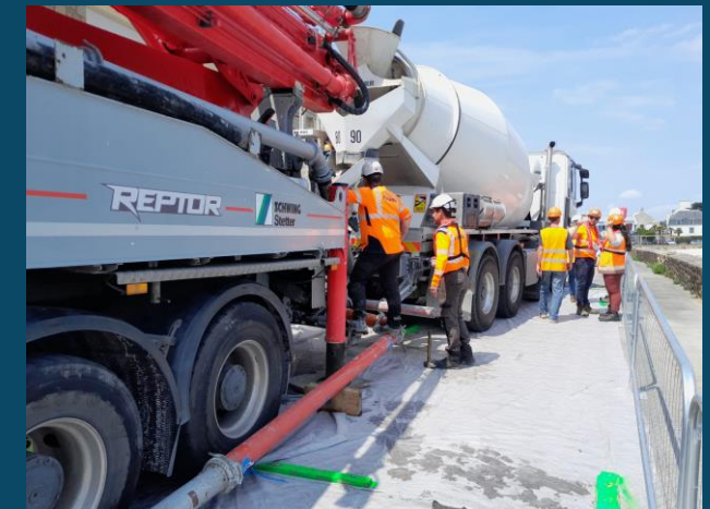
Géotextile de protection et système de collecte des eaux de lavage
