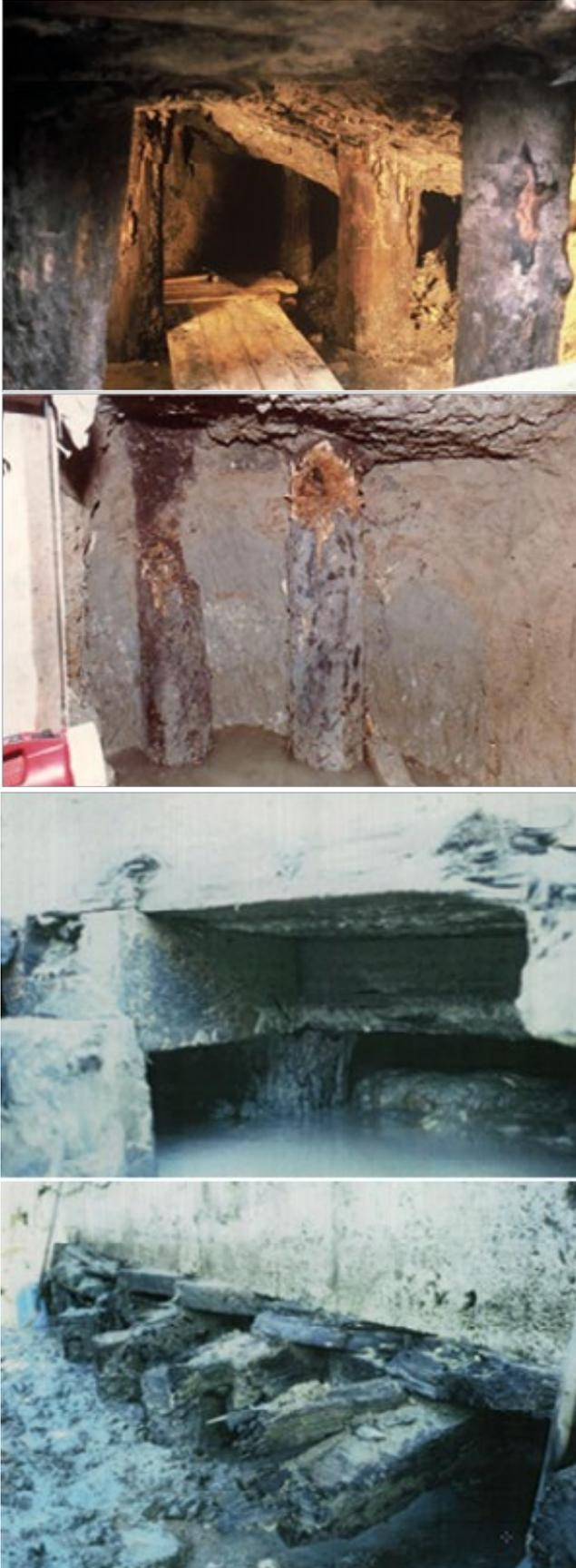
Figure 52 : Fondation sur plateforme en charpente et pieux en bois recépés juste sous l'étiage (pont Cessart Saumur)
