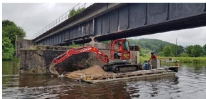
Figure 110 : Illustration d'un dégarnissage localisé réalisé à la pelle mécanique depuis un ponton flottant (crédit photo Romaeuf)
