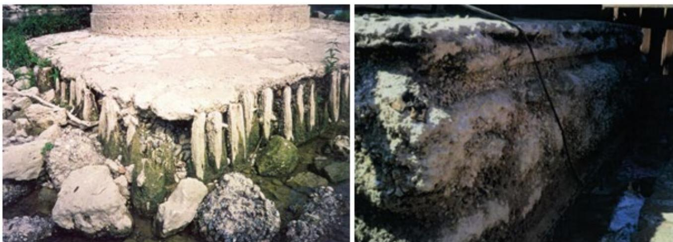
Figure 56 : Illustrations de massifs en béton de chaux dégradés (photos SNCF)
