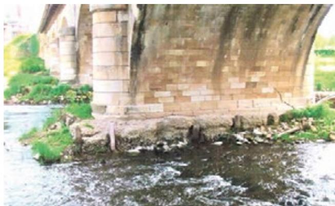
Figure 22 : Fondation sur massif de béton de chaux coulé derrière un rideau de vannage en bois qui, sur cet ouvrage sur le Cher, est détruit (crédit photo Hydro géotechnique)
