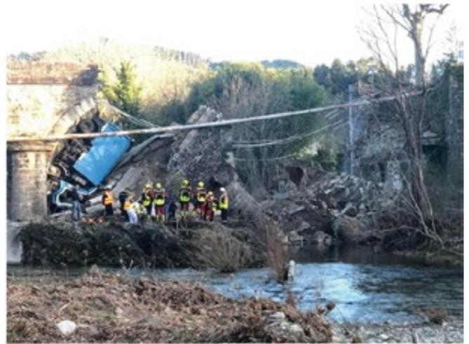
Figure 60 : Effondrement du pont de Chamborigaud en Cévennes dans le Gars en mars 2024 consécutif aux crues ayant affouillé une culée (crédit SDIS 30)
