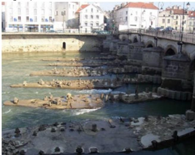
Figure 82 : Pont des moulins de Meaux - découverte des fondations anciennes d'un ouvrage en période d'étiage démontrant la baisse de ce niveau par rapport à l'époque de construction (photo 2004 d'un particulier amateur)
