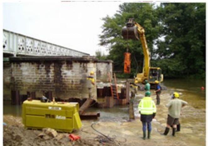
Figure 127 : Réalisation de battage de palplanches
