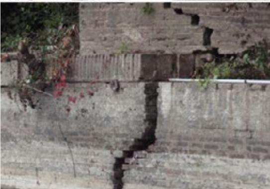
Figure 59 : Illustrations de fractures de structures d'ouvrages induites par des tassements d'appuis (photo 2 viaduc d'Orzilhac avant sa démolition extraite de «Inventaire 43041,02Y» Ponts et Viaducs détruits et/ou disparus, photo 3 DRIEA Ile de France)
