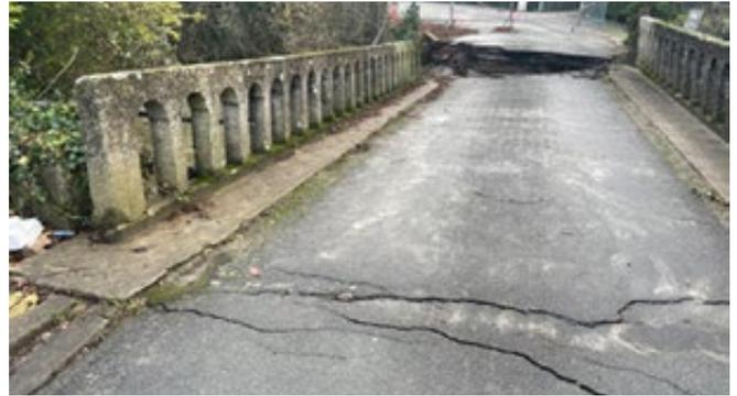
Figure 98 : Pont situé sur la commune d'Arques qui a subi de plein fouet les problèmes d'affouillement suite aux inondations (Image STRRES post LinkedIn)
