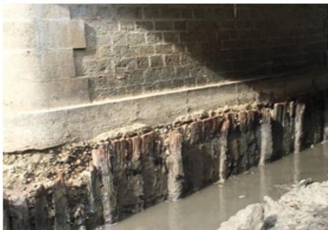
Figure 75 : Illustration de mise à l'air d'éléments bois suite à l'abaissement de la ligne d'eau (crédit photo Romeouf)
