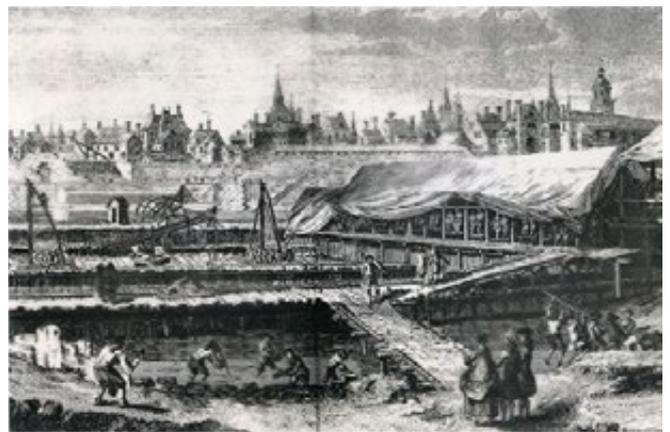
Figure 7 : Grand batardeau de construction du pont d'Orléans en 1751 (extrait de Construire des ponts au XVIII<sup>e</sup> siècle, presse ENPC 1986)
