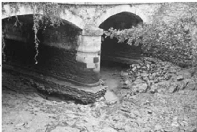
Figure 13 : Pont de Régereau sur le Vicoin édifié latéralement à la rivière qui sera ensuite déviée sous l'ouvrage. Semelle de maçonnerie de moellons reposant sur le schiste et affouillée par le courant arrivant de biais (crédit photo J-P Levillain)
