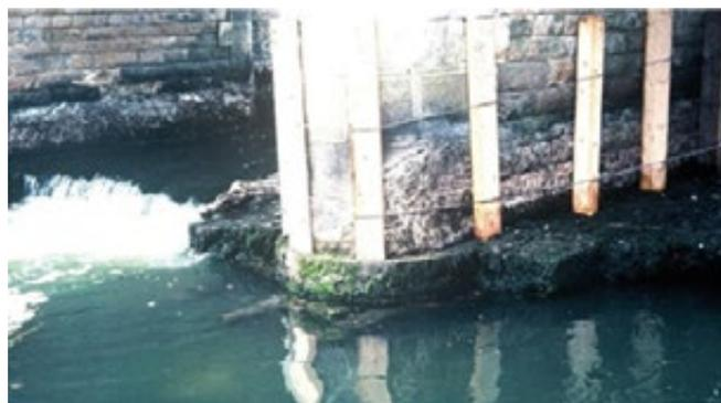
Figure 14 bis : Pont de Chasseneuil-du-Poitou sur le Clain. Semelle de fondation avec planches de réglage établie sans encastrement dans les alluvions graveleuses. Protection du lit par un radier de pavage de moellons ici affouillé par l'aval avec création de cavité sous la semelle par érosion régressive (crédit photo J-P Levillain).
