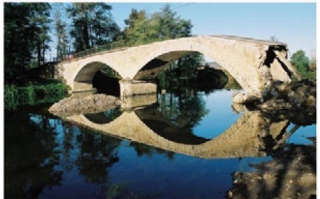
Figure 74 : Conséquence des dragages entraînant un abaissement de la ligne d'eau de 2 à 3 m et la chute du pont de Hères sur l'Adour quelques 20 ans après (photo extraite Journée technique «Les ponts en maçonnerie du diagnostic à la réparation» JP Levillain 12/10/2015)
