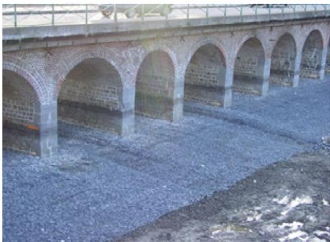
Figure 117 : Illustration d'un tapis de gabions (photo CETE Nord Picardie)
