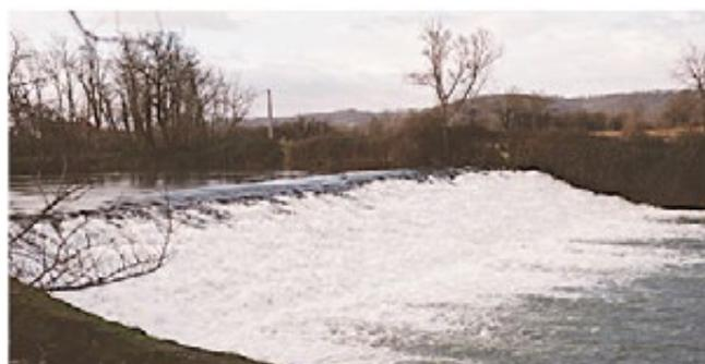
Figure 77 : Illustration d'un seuil (photo JP Levillain)
