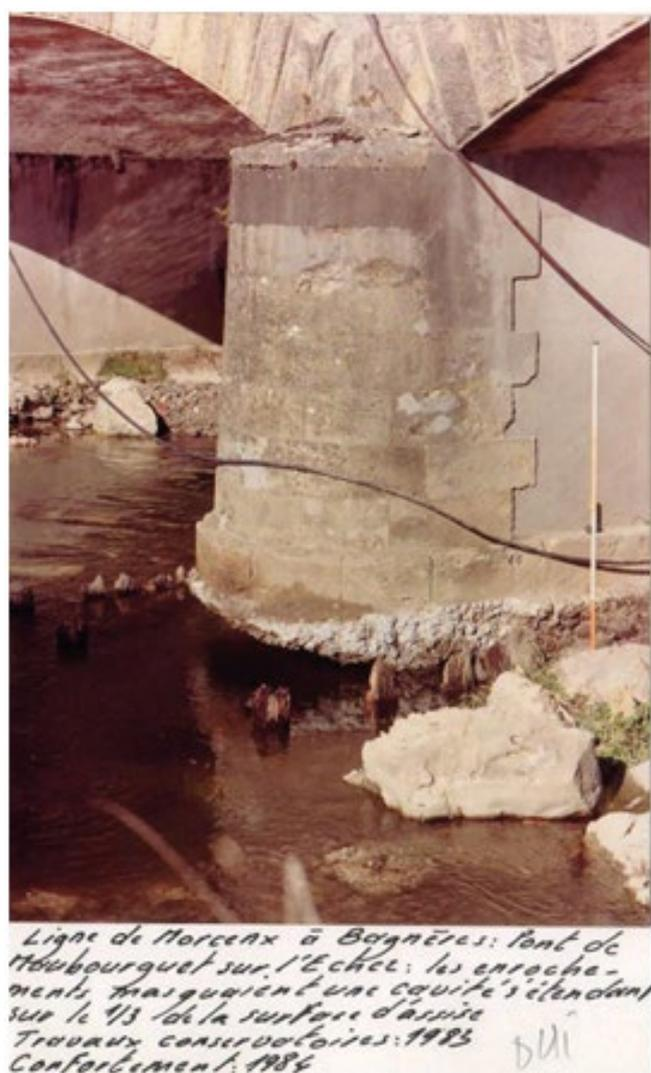
Figure 51 : Illustration de l'érosion, abrasion des matériaux des éléments constituant les fondations, et de la création d'une fosse d'érosion du lit en aval (photo archive SNCF, extrait présentation technique « Gestion d'un patrimoine d'ouvrage sur Pieux bois - Diagnostic, pathologies et renforcement du 25/01/2021 »)
