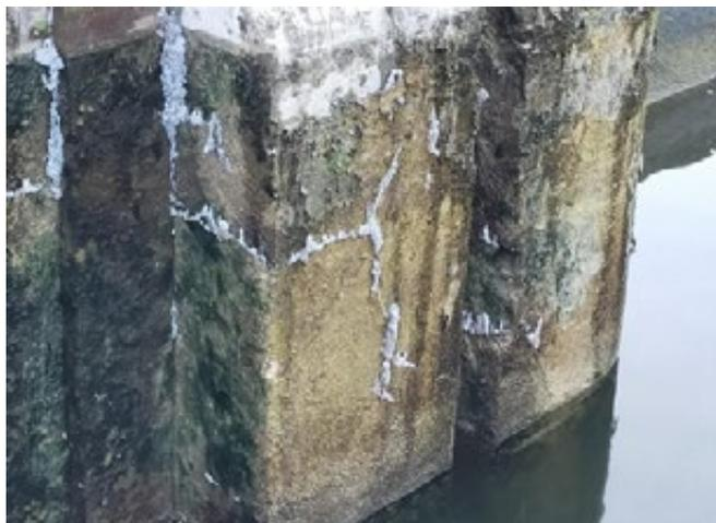
Figure 144 : Illustration de résurgence de résine maîtrisée sur un parement (crédit photo URETEK)
