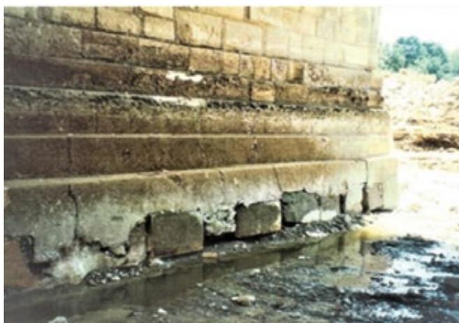
Figure 9 : Semelle de fondation de blocs taillés reposant sans encastrement sur le substratum rocheux. Pont Henri IV sur la Vienne à Châtellerault construit de 1556 à 1609 (crédit photo J-P Levillain)
