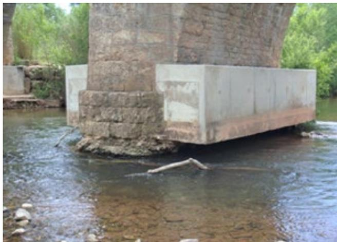
Figure 129 : Illustration d'encagement réalisé en coffrage traditionnel, insuffisamment ancré et d'emprise importante ayant engendré des affouillements.
