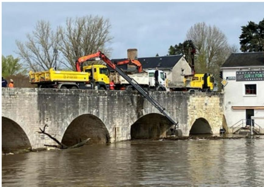
Figure 92 : Crue d'avril 2024 dans le loir et Cher, intervention d'ATS pour débayer les embâcles accumulés (crédit photo ATS)
