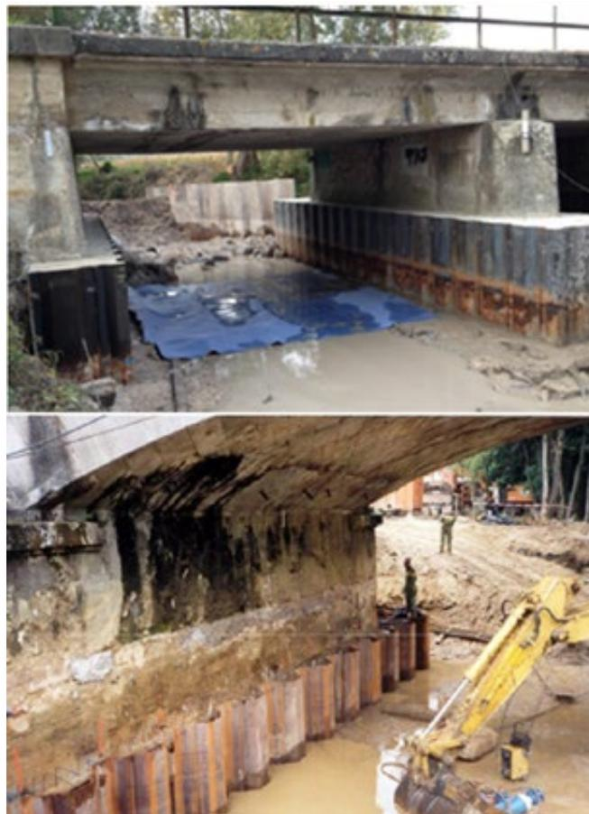
Figure 131 : Illustrations d'encagements correctement ancrés grâce à un rideau de palplanches et réalisés avec des emprises réduites limitant ainsi les perturbations hydrauliques (crédit photos Romoeuf)
