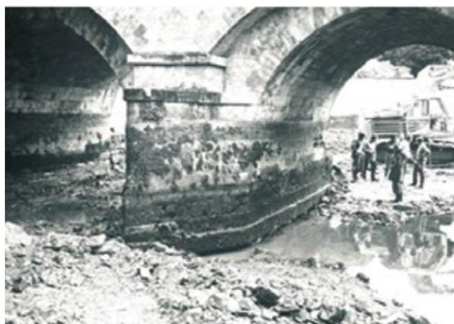
Figure 10 : Vieux pont de Niort sur la Sèvre Niortaise de 1645, élargi en 1747. Fondation établie sur plancher bois reposant sur les alluvions sablo-graveleuses du lit (crédit photo J-P Levillain)
