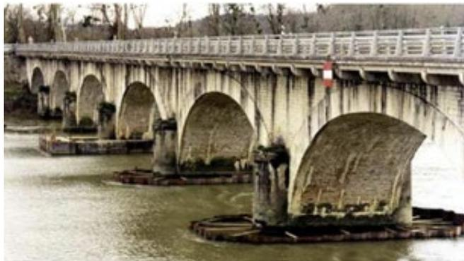
Figure 121 : Illustration d'encagement des appuis par rideaux de palplanches (crédit photo JP Levillain)
