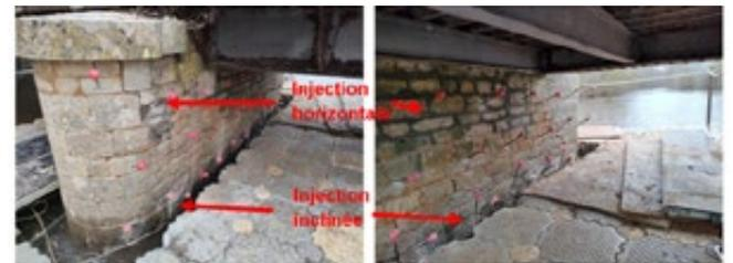
Figure 142 : Injection de résine des piles du Pont de St Maxire (79) (crédit photo URETEK)
