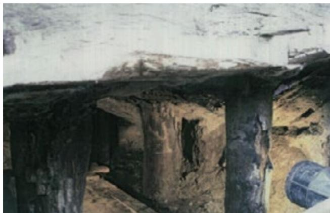
Figure 34 : Pont Cessart sur la Loire à Saumur (1755-1767) pile 3 sur 116 pilots recépés entre 2,50 m et 4,50 m sous l'étiage (crédit photo J-P Levillain)
