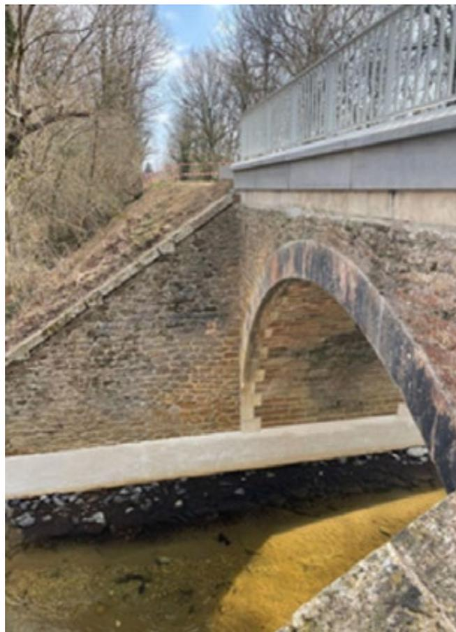
Figure 116 : Ouvrage de Luzou sur la ligne ferroviaire Luluque Tartas dans les Landes : affouillement important sous une culée fondée sur pieux bois, comblé par enrochement permettant de retenir les sédiments sableux et recombler naturellement l'affouillement (Crédit photo BTPS Atlantique)
