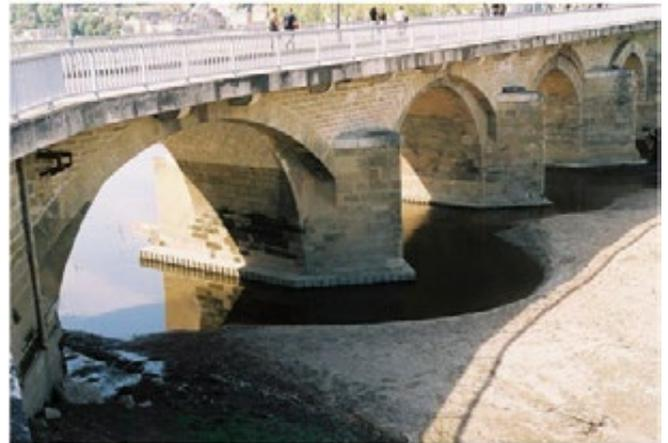
Figure 65 : Illustration de fosses d'affouillement dues à la présence des piles (photo JP Levillain)
