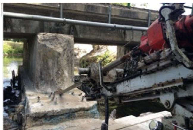
Figure 137 : Illustration de forage oblique d'une pile (crédit photo SAS Romaeuf)
