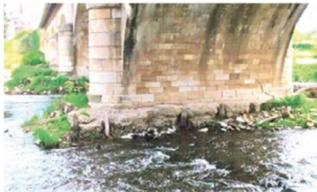
Figure 50 : Illustration de l'érosion, abrasion des matériaux des éléments constituant les fondations
