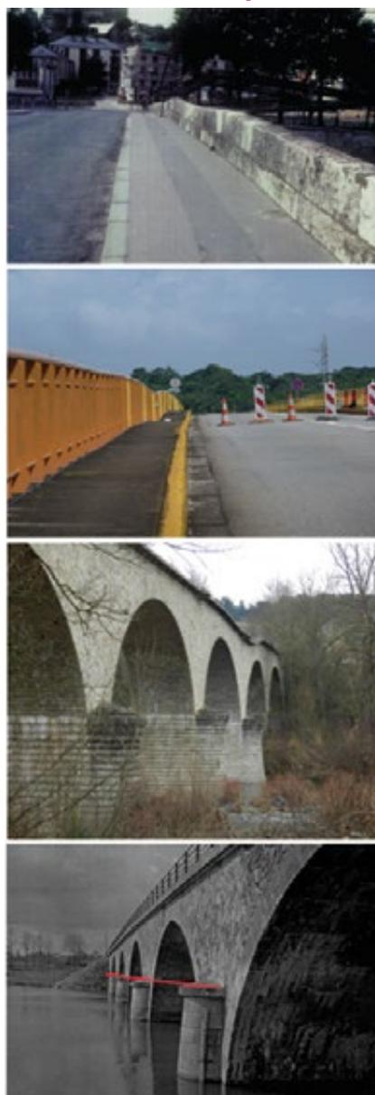
Figure 58 : Illustrations des déformations du profil en long d'ouvrages (photos 1 et 5 extraites présentation JP Levillain Journée technique «Les ponts en maçonnerie du diagnostic à la réparation» du 12/10/2015, photo 2 CETE de l'Ouest, photos 3 et 4 CETE de Lyon)
