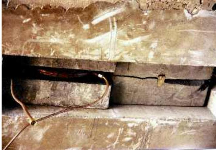
Photo n° 79 : vêrin provisoire à gauche et bloc vêrin définitif à droite (crédit photo Division des Ouvrages d'Art du CETE de l'Est)
