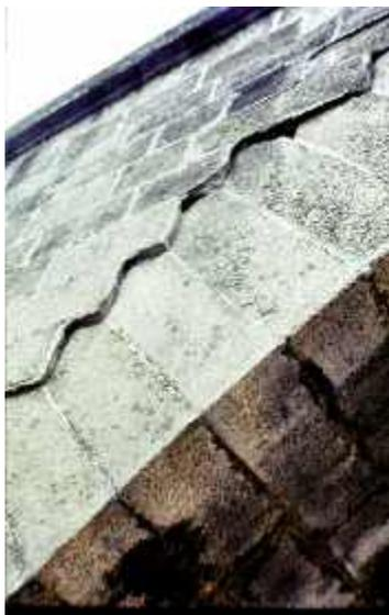
Photo n° 32 : décollement entre le tympan et le bandeau du pont du nid d'oise à Clisson
