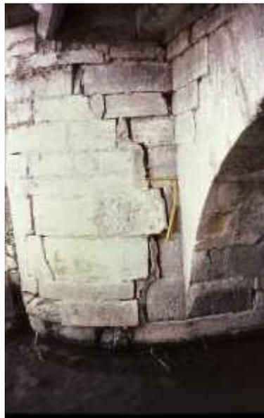
Photo n° 92 : désordres dus à l'appui de l'élargissement sur un avant-bec mal fondé (crédit photo LRPC)
