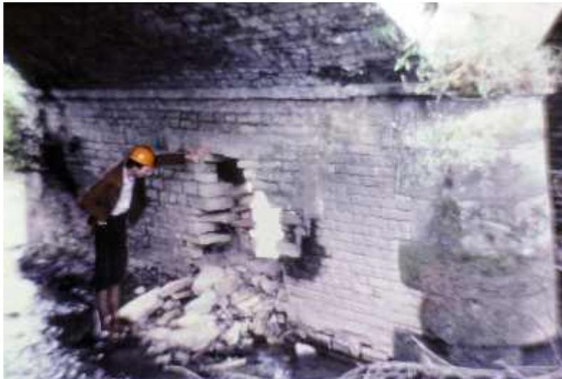
**Photo n° 3 : effondrement partiel d'une pile en maçonnerie** (crédit photo DDE 70)
