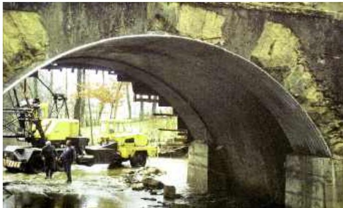
Photo n° 72 : coffrage avec des éléments de buse, ici uniquement au niveau de la base des voiles en béton armé de renforcement des murs tympan (crédit photo Michel Daugreilh)<sup>17</sup>
