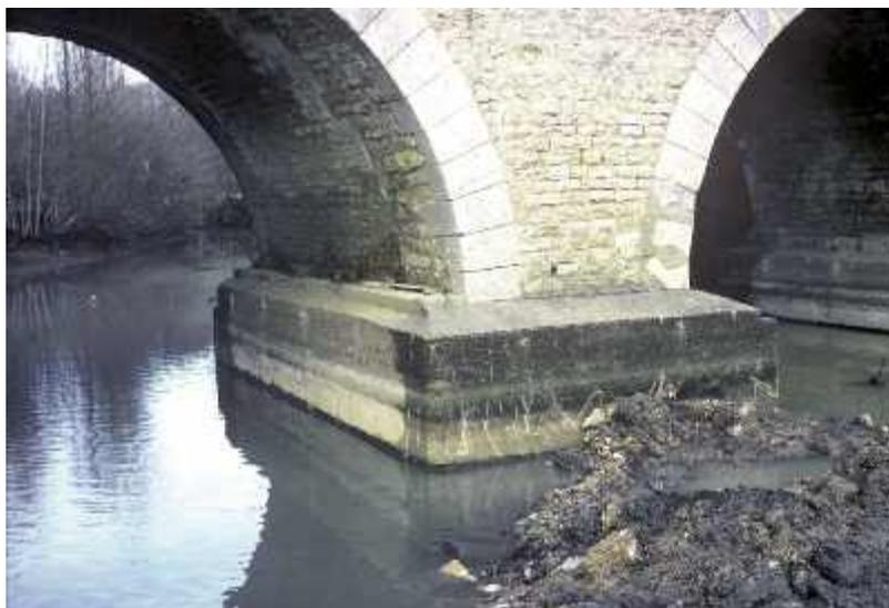
*Photo n° 16 : élargissement de la base d'un appui par un voile en béton. Bien souvent, un "cache-misère" donnant l'illusion de la sécurité (crédit photo JP. Levillain)*
