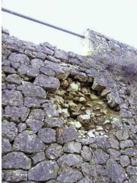
**Photo n° 2 : effondrement partiel d'un mur** (crédit photo Cofex Littoral)
