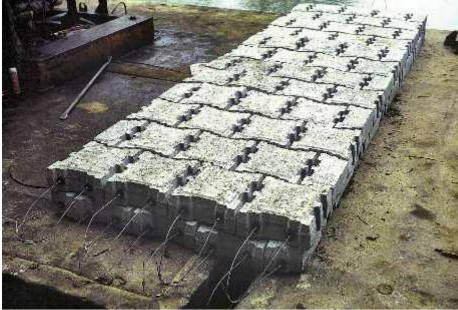
Photo n°13 : élément préfabriqué pour radier préfabriqué (crédit photo JP. Levillain)
