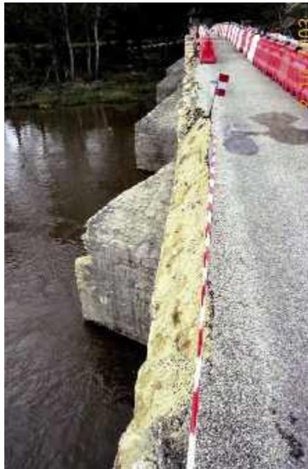
*Photo n° 1 : résultat d'un choc sur le parapet d'un pont en maçonnerie (crédit photo Cofex Littoral)*
