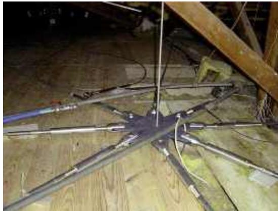
*Photo n° 45 : pièce centrale permettant la mise en tension des tirants fixés sur les différentes plaques d'ancrage*
