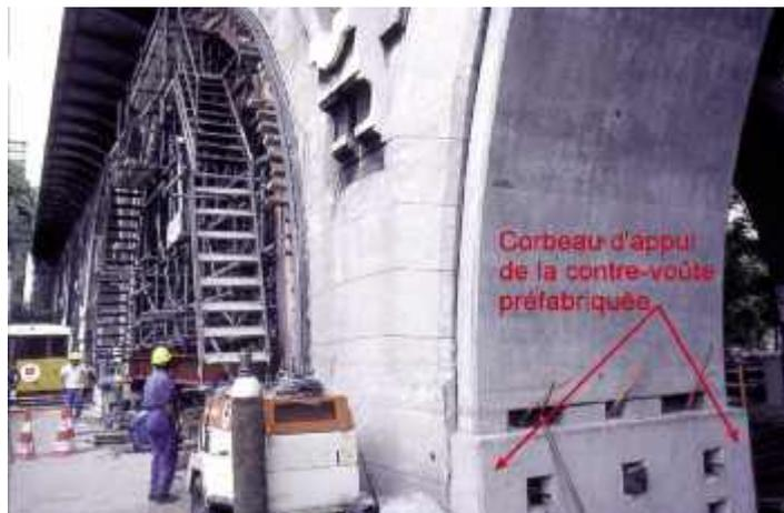
Photo n° 70 : longrine d'appui en partie basse de la contre-voûte préfabriquée du pont de Levallois (crédit-photo D. Poinéau)
