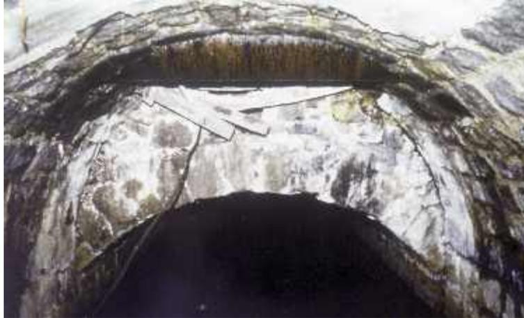
Photo n° 96 : mauvaise réalisation du joint longitudinal entre l'ancien et le nouvel ouvrage et débouchés superficiels très différents (crédit photo CDOA Corse)
