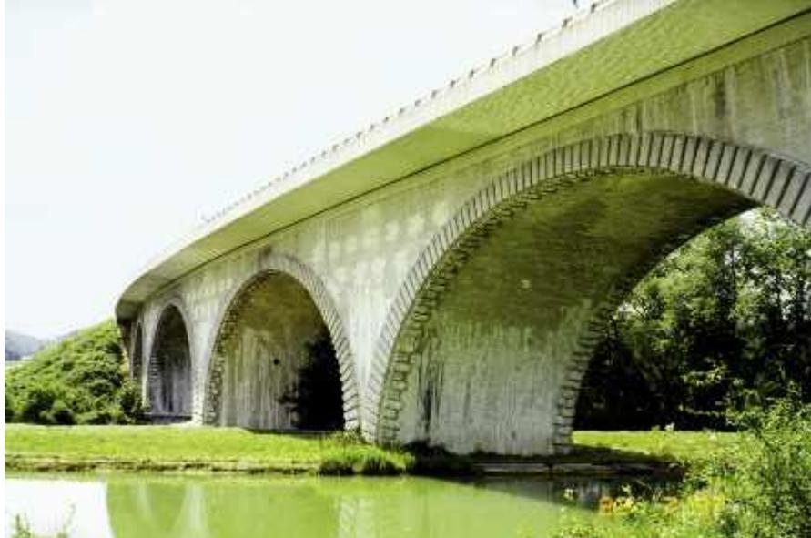
Photo n° 91 : pont de dit de 100 mètres après élargissement par une dalle générale appuyée sur le remplissage
