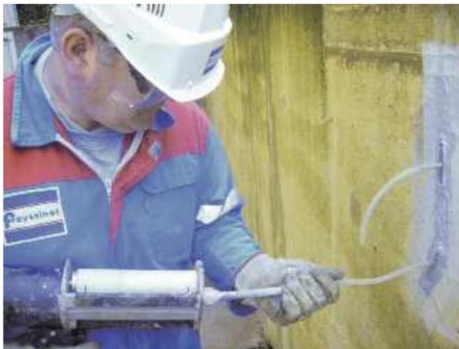
**Photo n° 58 : pistolet manuel d'injection** (crédit photo Freyssinet)
