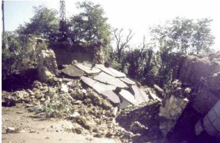
*Photo n° 84 : effondrement du pont du Réart causé par des travaux sur les fondations (crédit photo D. Poineau)*
