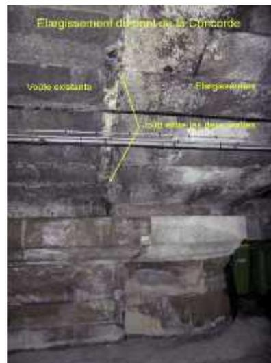
**Photo n° 94 : détail de l'élargissement du pont de la Concorde** (crédit photo D. Poinéau)
