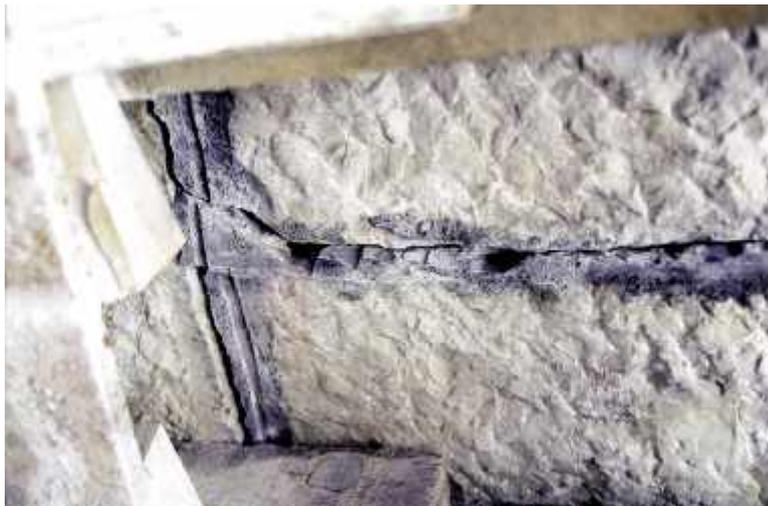
*Photo n° 83 : ouverture du joint accompagnée d'un déplacement transversal en l'absence d'épingles ou de tirants d'enserrement
