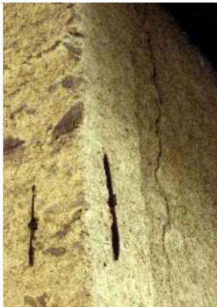
Photo n° 36 : tirants d'enserrement d'un bâtiment dans les Hautes-Alpes (crédit photo D. Poineau)
