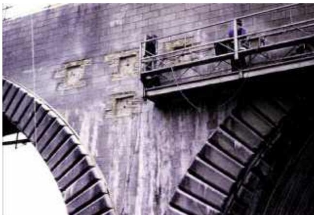
Photo n° 63 : pont dit de 100 mètres, niches de logement des ancrages (crédit photo DDE 52)
