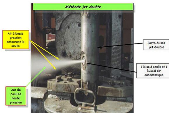
Le traitement par jet grouting conduit à réaliser des éléments rigides d'un mélange de sol ciment, dont la mise en œuvre fait appel à trois phénomènes distincts intervenant indépendamment ou en combinaison :
