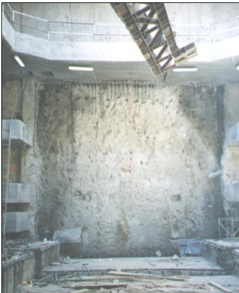
Photo n° 9 : exemple d'un mur jet étanche entre deux parois moulées (photo Solétanche Bachy).
