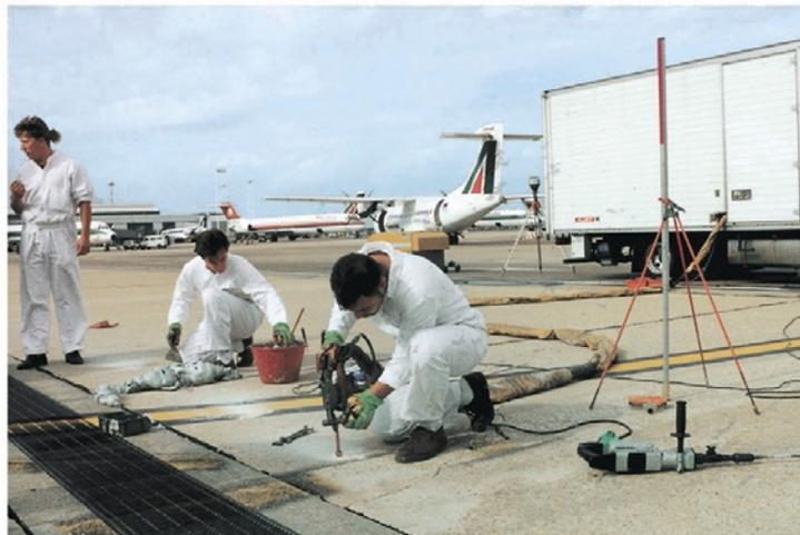
Photo n° 3 : élimination de battements de dalles (photo URETEK).
