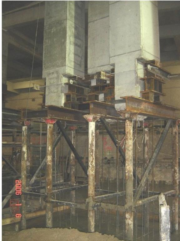
Photo n° 11 : reprise en sous-œuvre par micropieux.
