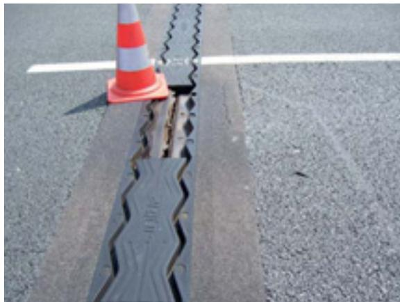
**Figure 8 :** L'arrachement sous trafic de l'élément manquant aurait pu être à l'origine d'un accident (noter la condamnation au trafic de la voie concernée). Crédit photo M. Fragnet
