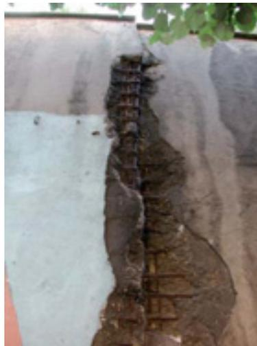
Figure 12 : Epaufrures des lèvres par mise en contact suite à un mouvement de structure ou d'insuffisance de hiatus pour la dilatation, ou une combinaison des deux. Crédit photo SETRA - G. Haiun
