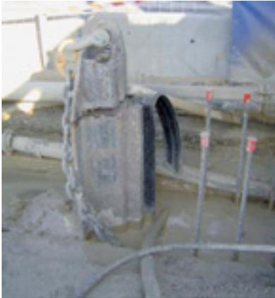
**d) Joint par bande d'étanchéité en attente sur une paroi moulée.**
