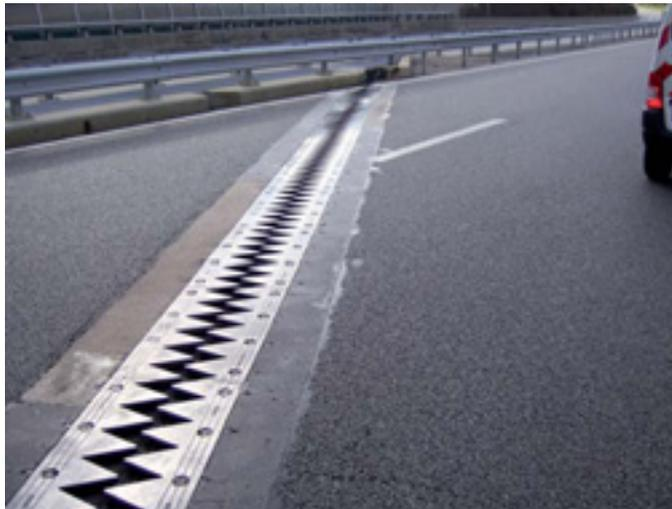
**Figure 11** : Lors de la visite, on doit se demander si ce joint n'est pas trop ouvert eu égard à la température de l'ouvrage au moment de la visite. Crédit photo M. Fragnet
