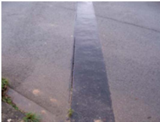
Figure 9 a : Fissure au droit du trait de scie
