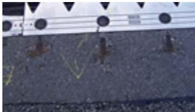
Rupture de dent, fissure dans le métal, fissuration du solin
