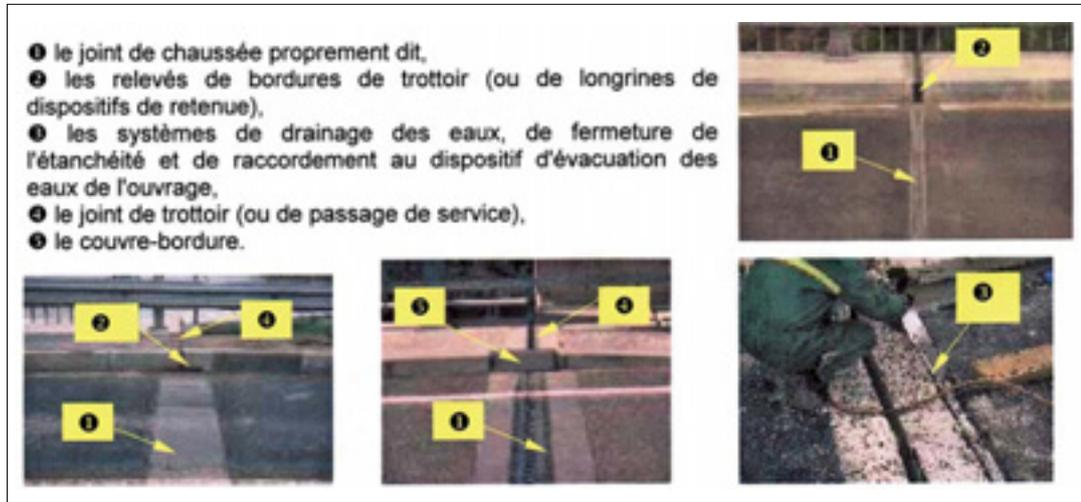
**Figure 2 : Composition d'un «kit» de joints de chaussée d'un pont routier - Document SETRA**
