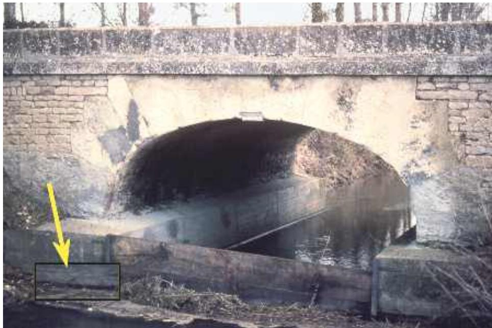
**Photo n° 10 : affaiblissement sous la fondation d'une des culées dû à la mise en place d'un barrage** (crédit photo LRPC)
