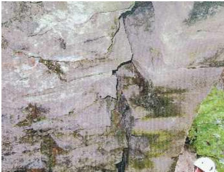
Photo n° 12 : maçonnerie en très mauvais état qui ne peut être considérée comme homogène (crédit photo DDE 74)
