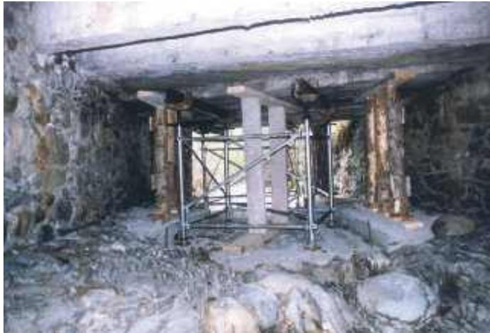
*Photo n° 8 : étalement de sécurité d'un tablier en dalles de pierre fissuré (crédit photo DDE 65)*
