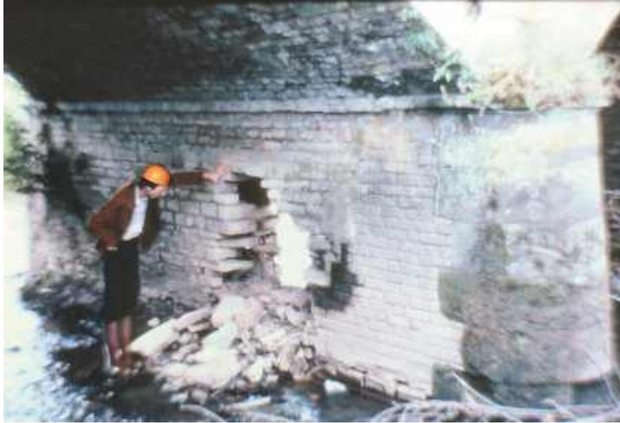
Photo n° 9 : mauvaise qualité du remplissage intérieur d'une pile du pont de Luze (crédit photo DDE 70)
