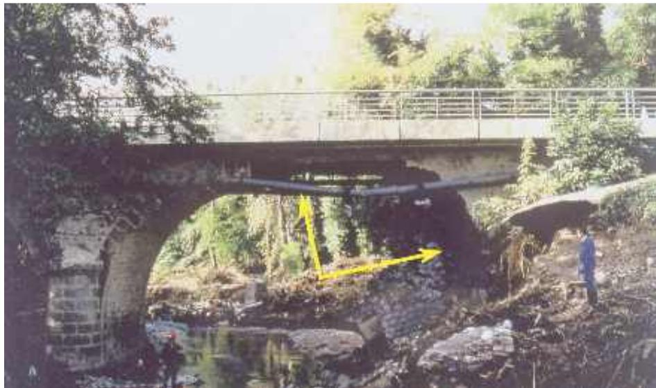
Photo n° 7 : conséquences sur une voûte d'affouillements pendant une crue (crédit photo DDE 84)
