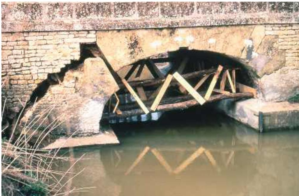
**Photo n° 11 : l'étalement inadapté mis en place n'a pas empêché l'effondrement de la culée** (crédit photo LRPC)
