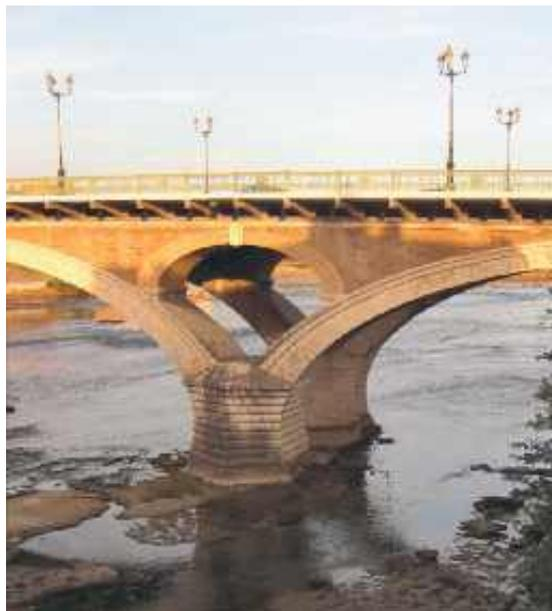
Photo n° 7 : pile de section optimisée du pont Catalans (ex-pont des Amidonniers) à Toulouse (crédit-photo D. Poineau)
