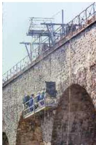
**Photo n° 2 : aqueduc d'Arcueil-Cachan, échafaudage volant pour des travaux de ragréage**
