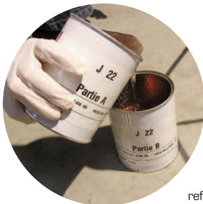
Photo n° 37 : le produit A est versé avec soin et en totalité dans le pot de produit B (crédit photo Freyssinet)
