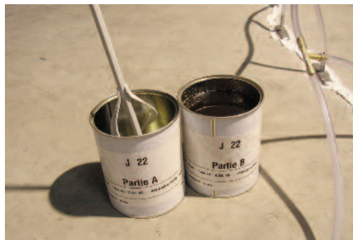
Photo n° 12 : fin du malaxage de la résine et du durcisseur (crédit photo Freyssinet)
