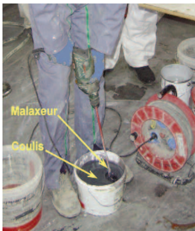
Photo n° 13 : malaxage d'un coulis pour injection à base de liants hydrauliques (crédit photo Parexlanko)
