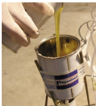
Photo n° 17 : remplissage d'un réservoir à simple pression gravitaire (crédit photo Freyssinet)
