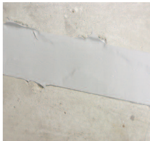
Photo n° 6 : calfeutrement d'une fissure à l'aide d'un mastic à base de liants organiques (crédit photo Freyssinet)
