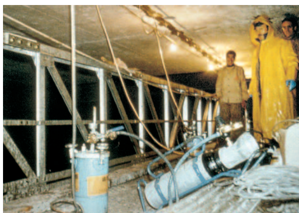
Photo n° 36 : injection de nuit au pont sur l'Arve II (crédit photo CÉTÉ de Lyon)
