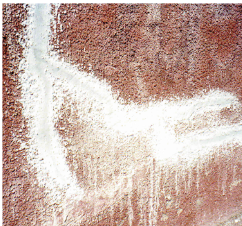
Photo n° 5 : calfeutrement de fissures à l'aide d'un mortier à base de liants hydrauliques (crédit photo Poineau)
