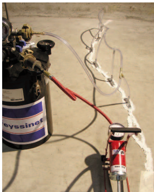
Photo n° 39 : exemple d'injection par groupe d'événements (crédit photo Freyssinet)
