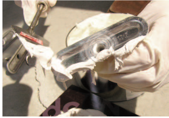
Photo n° 33 : encollage avant mise en place des événements collés (crédit photo Freyssinet)
