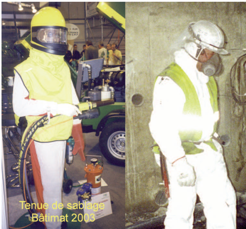
Photo n° 48 : équipements de protection individuelle (crédit photo Poineau)
