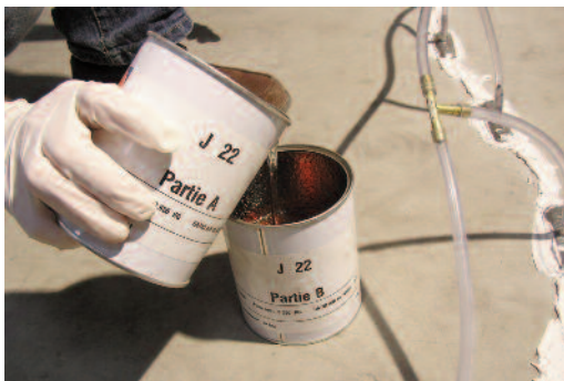
Photo n° 11 : début du mélange résine et durcisseur (crédit photo Freyssinet)
