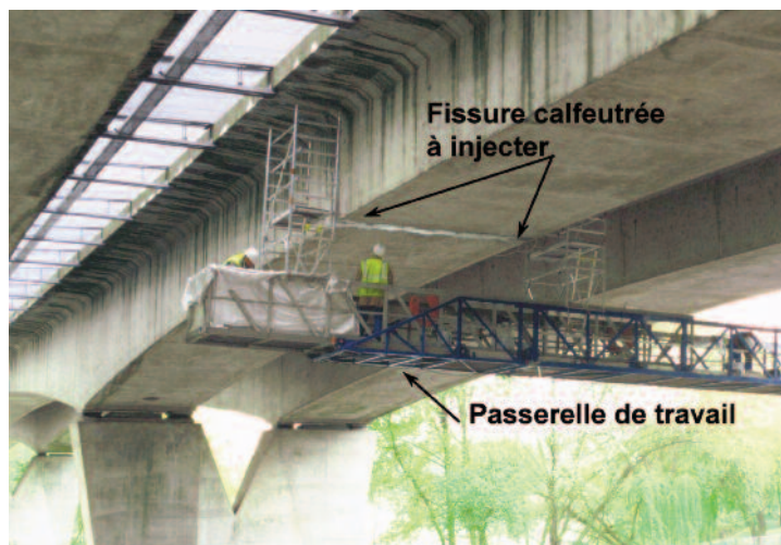
Photo n° 42 : chantier d'injection (crédit photo Parexlanko)
