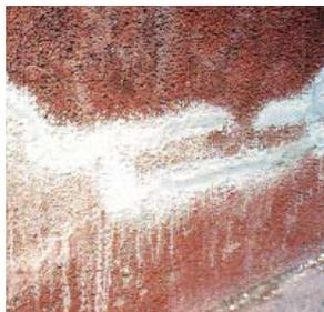
Photo n° 2 : calfeutrement de fissures à l'aide d'un mortier à base de liants hydrauliques (photo Poineau)
