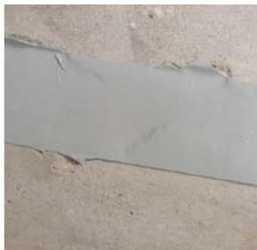
Photo n° 3 : calfeutrement d'une fissure à l'aide d'un mastic à base de liants organiques (photo Freyssinet)
