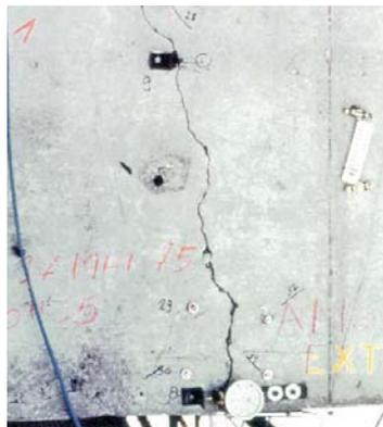
Photo n° 6 : fissure due à une insuffisance de résistance à la flexion d'une poutre en béton précontraint (photo LRPC d'Aix-en-Provence).
