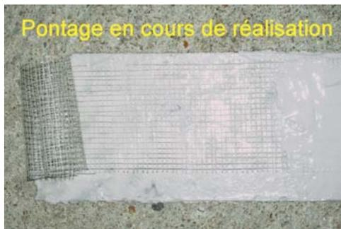
Photo n° 26 : réalisation d'un pontage en mortier à base de liants de synthèse armé (photo Freyssinet)
