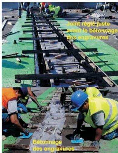
Photo n° 31 : avant la pose d'un joint de dilatation
