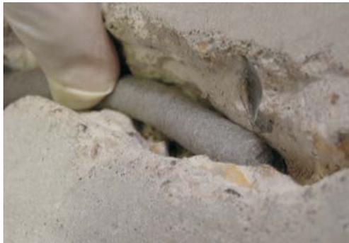
Photo n° 20 : mise en place du fond de joint
