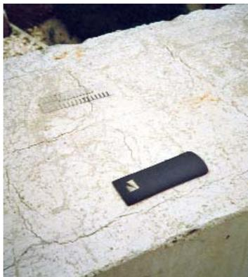
Photo n° 5 : fissures caractéristiques des cassures dites du béton frais (photo Poineau).
