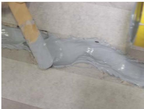
Photo n° 22 : réalisation d'un calfeutrement
