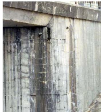
Photo n° 7 : fissuration due à une alcali-réaction du piédroit d'une culée (photo Poineau).
