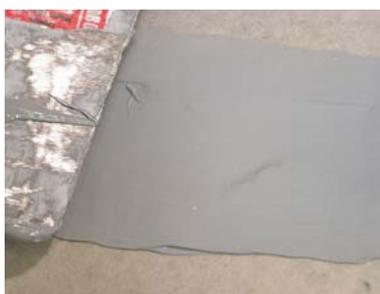
Photo n° 23 : lissage de finition du calfeutrement
