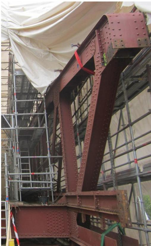
Remplacement des montants d'about : rendu possible grâce à la zone d'appui utilisée pour le vérinage de l'ouvrage
