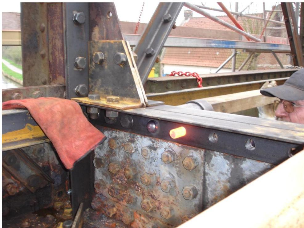
Réparation à l'identique – pose de rivets à chaud
