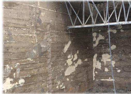
*Dépose d'étanchéité de type PAX-ALU, gommage pelliculaire basse pression puis nettoyage vapeur*
