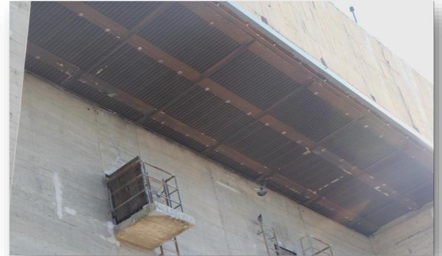
*Afin de ne pas générer de pile électrochimique entre les ancrages inox de maintien des filets et les aciers du bâtiment.*
