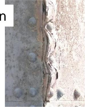
Fatigue sur assemblage soudé
