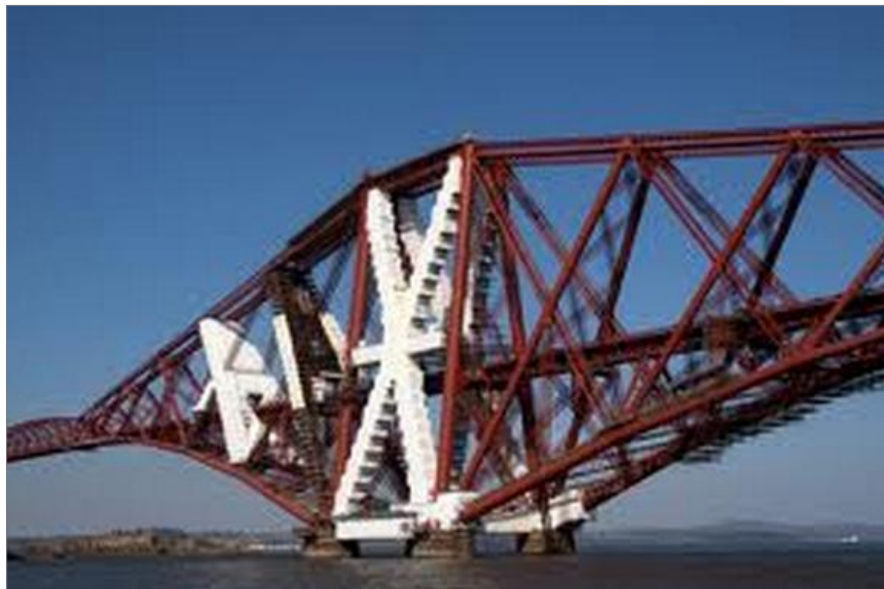
Exemple d'échafaudage et de confinement
