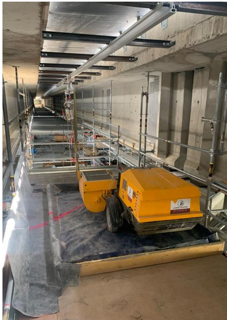
Mise en place d'un monorail avec treuil par SkyAccès
