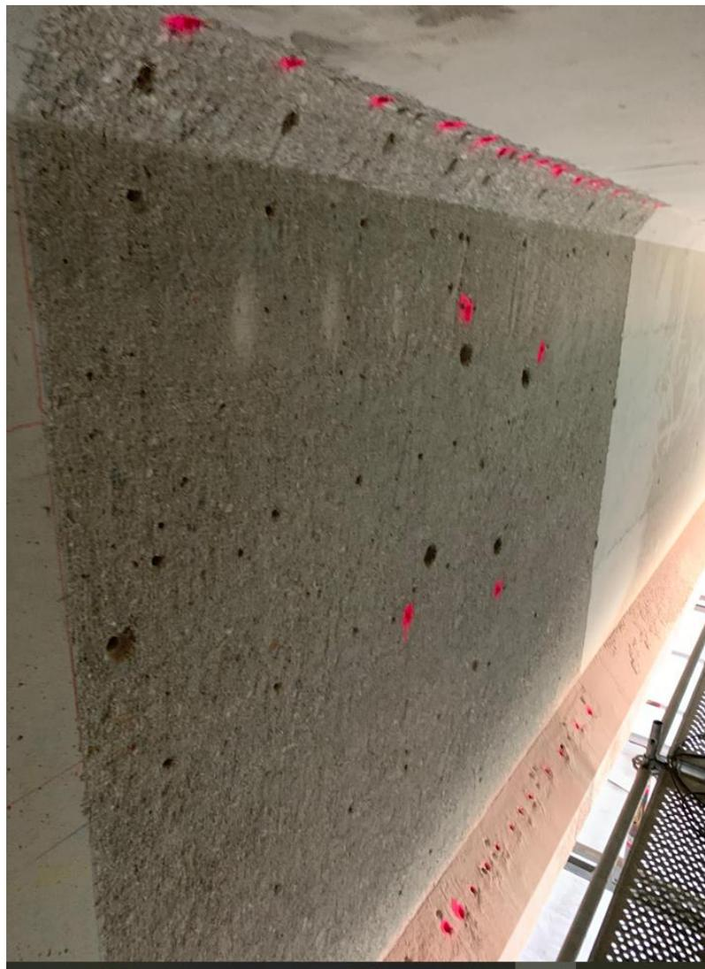
Après percements de l'ensemble des trous et des carottages, réalisation du bouchardage du l'ensemble de la surface
