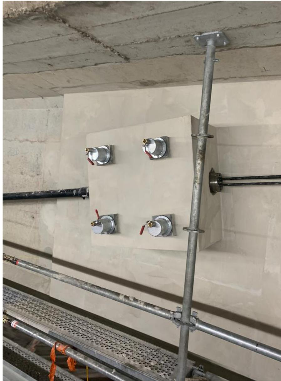
Mise en place des capots de protections pour injection à la cire pétrolière
