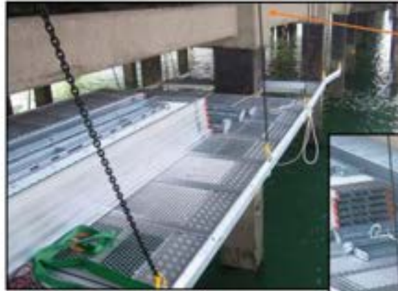
Poutres suspendues aux chaines
