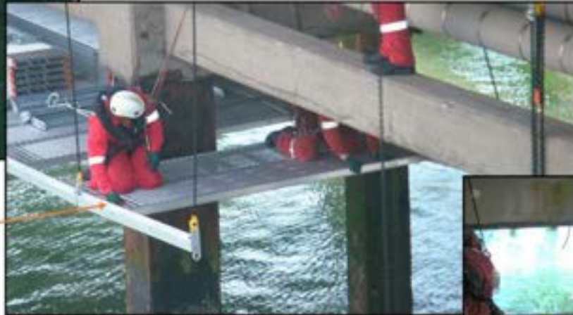
Plateaux fixés aux poutres
