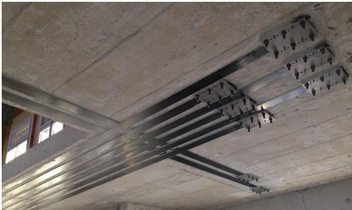
Renforcement vis-à-vis des problèmes de déformation
